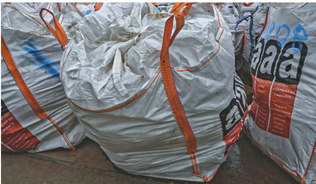
Ordnungsgemäß verpackte Big Bags mit nichtklassischem Asbest.
