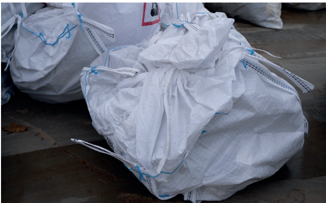
Ordnungsgemäß verpackter Big Bag mit Akustikdämmplatten.
