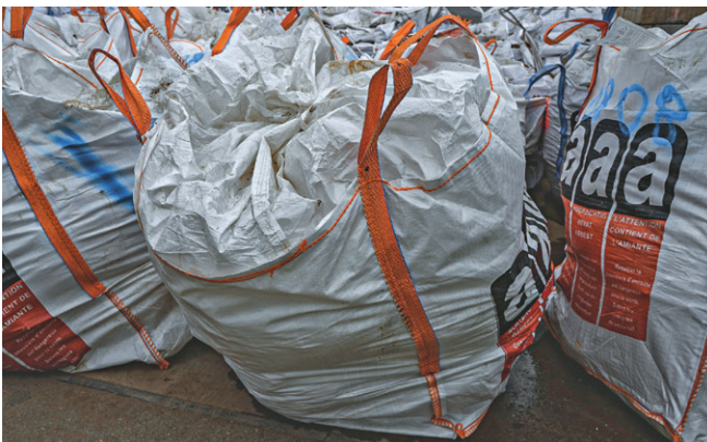
Ordnungsgemäß verpackte Big Bags mit klassischem Asbest
